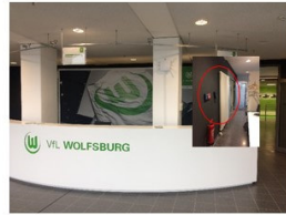
VIP-Empfang (hinter der Wand vom Tresen)
