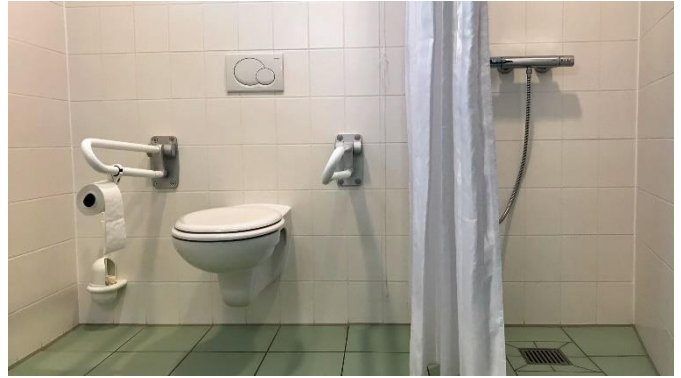
Barrierefreier Sanitärraum im Fanhaus
