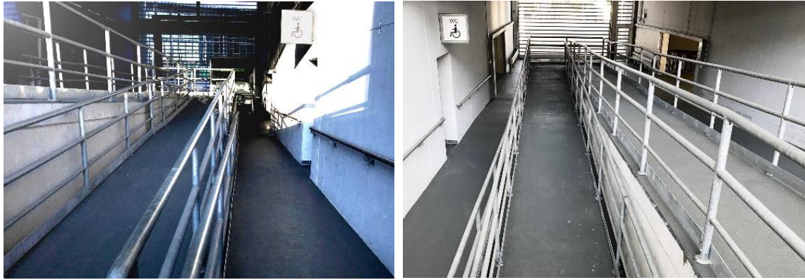
Rampe zu den Rollstuhlfahrerplätzen
