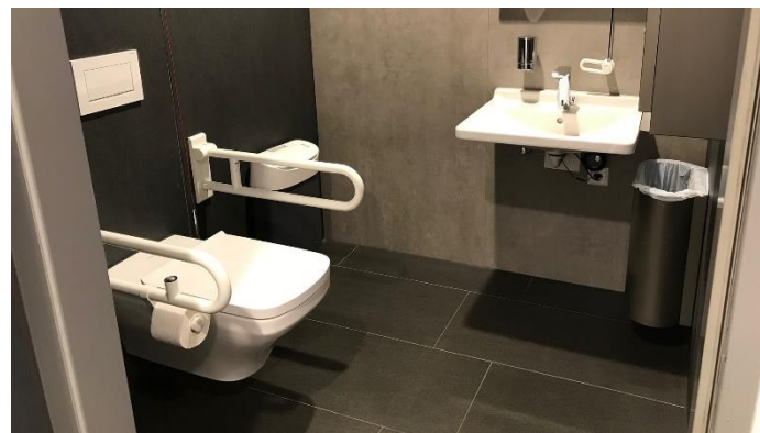
Barrierefreie Sanitärraum im VIP-Bereich
