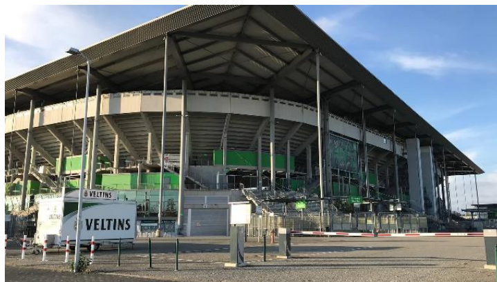
Einfahrt Parkplätze für Fans mit Behinderungen
