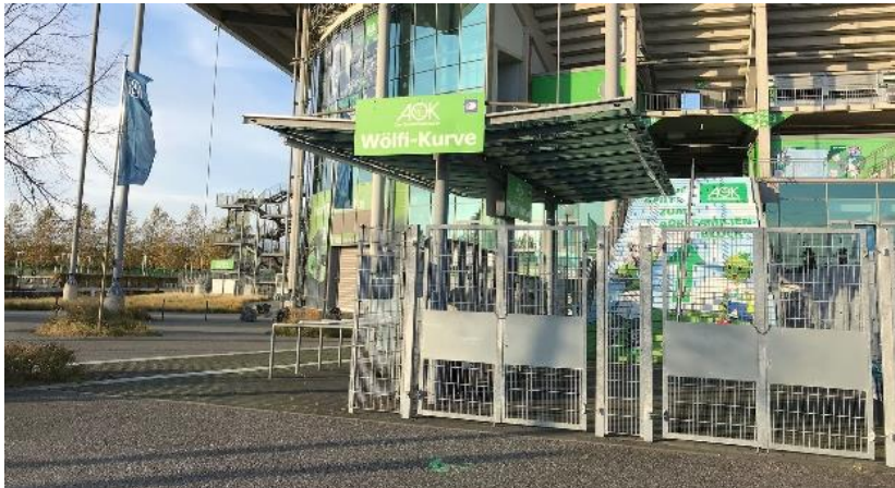
Eingang blinde und sehbehinderte Fans - Wölfikurve
