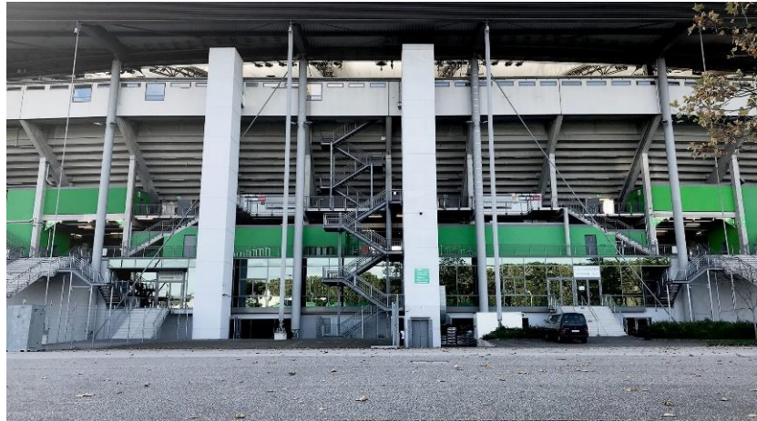
Treppenlift – Zugang zu Club 45 und Halle 09
