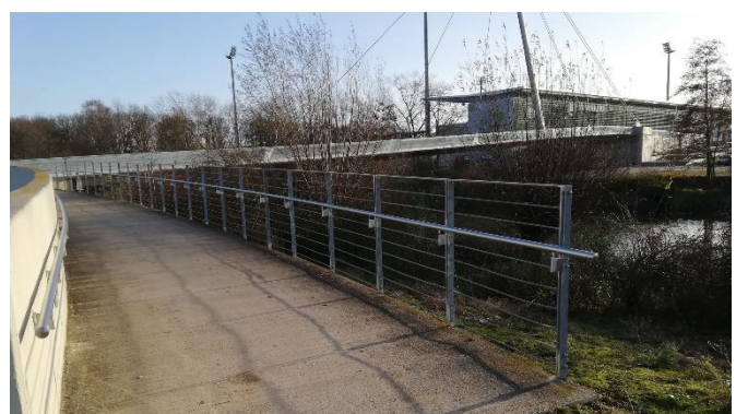
Rampe zum AOK Stadion auf der Nordseite (Allerpark)
